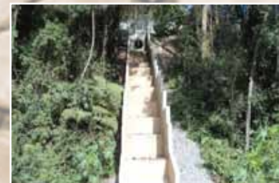
Sistema de drenagem (escada hidráulica).
