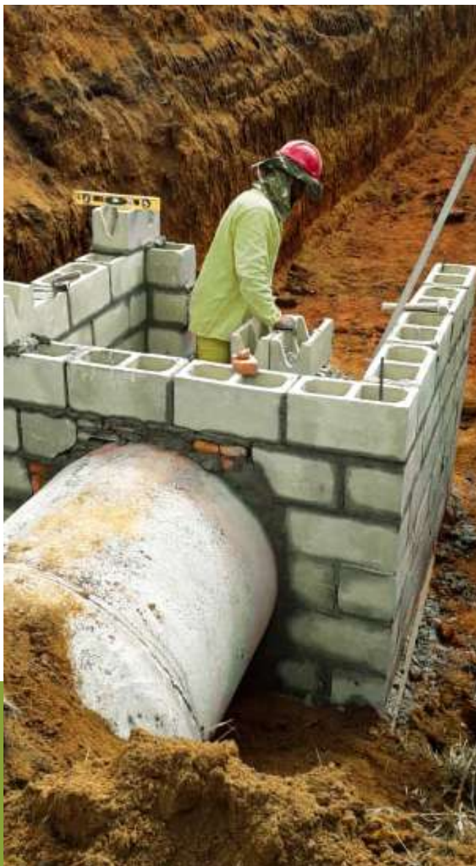
Construção da rede de drenagem no Residencial Rio Negro – Itaquaquetuba/SP.
